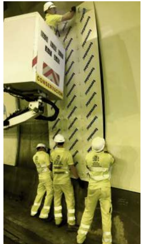
Forrado de tuneles
